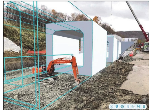
図-2 AR技術の活用事例「施工現場の活用①」 2)
