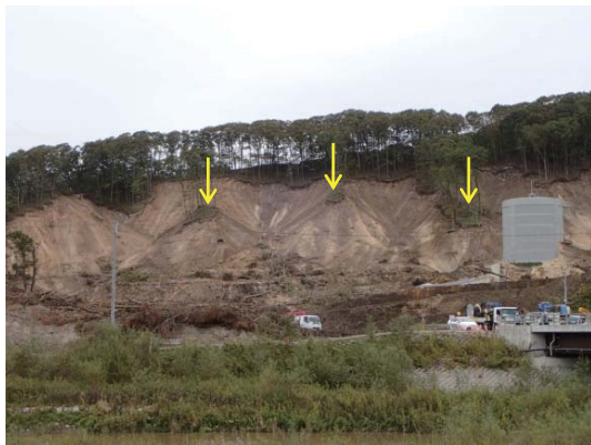
写真 2.2.23 富里地区崩壊地の遠景
