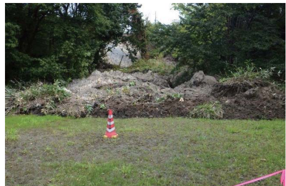
写真 3.2.2③ 清田区美しが丘の被害状況
