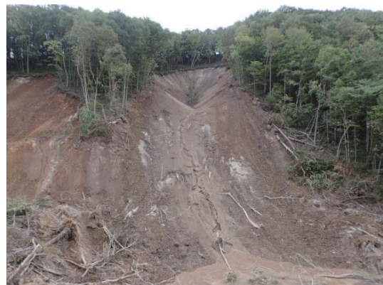
写真 2.2.28 崩壊地 B の遠景
