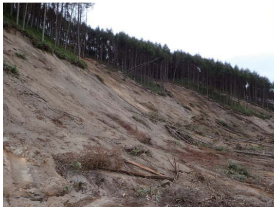
写真 2.2.29 崩壊地 C の遠景
