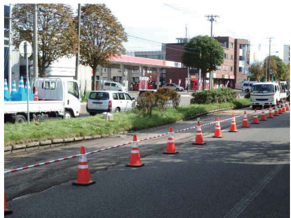
写真 3.3.2② 屯田通の被害状況(北 36 条付近)
