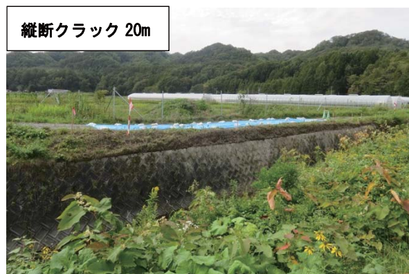
写真 5.1.4 沙流川 (支川) (二風谷ダム上流右岸 8.9k)
