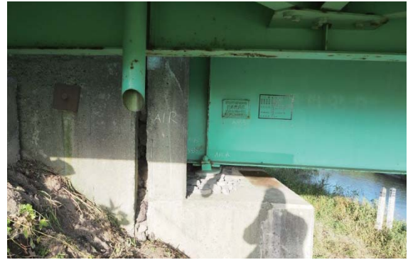
写真 4.1.33 A1 橋台の移動
