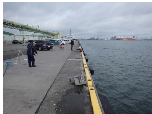
写真 6.1.1 南ふ頭の岸壁の状況
