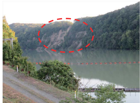
写真 5.2.2 川端ダム 貯水池左岸斜面崩壊
