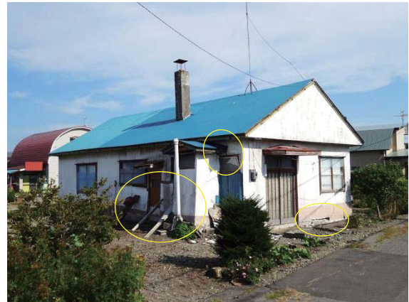
写真 7.1.3 安平町早来大町での建物被害
