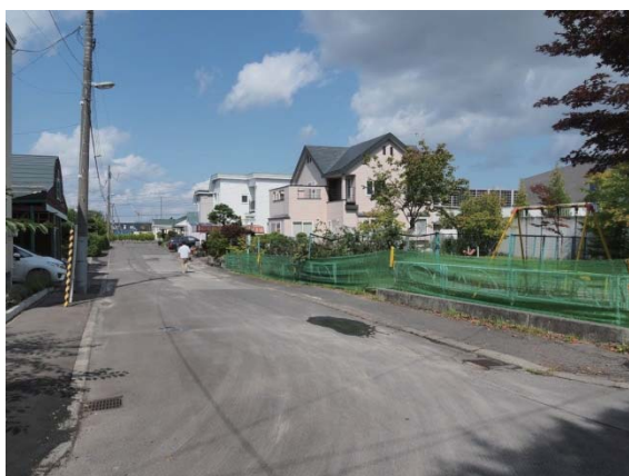
写真 3.2.2① 清田区美しが丘の被害状況
