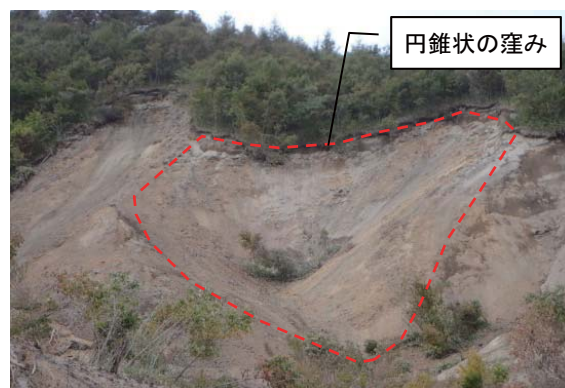
写真 2.2.15 崩壊地 B の頭部
