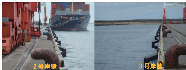
写真 6.1.13 岸壁法線の状況
