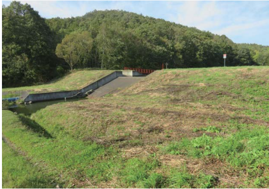
写真 5.2.16 ため池 堤体下流側
