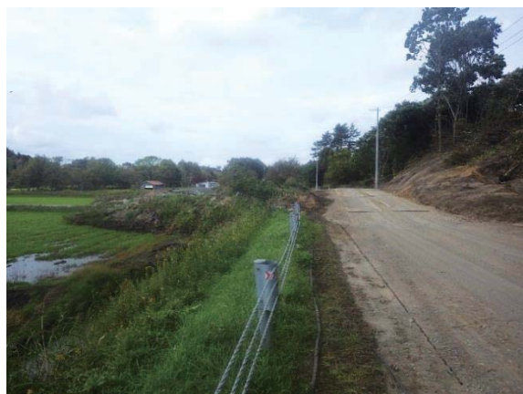
写真 2.2.4 水田に侵入した崩積土と道路の 応急復旧状況
