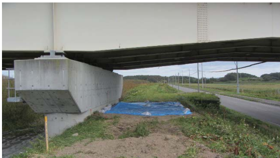
写真 4.1.7 橋脚背面の堤防の応急処置
