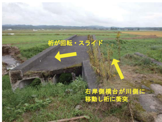
写真 2.2.9 農道橋の桁の回転
