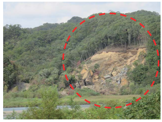
写真 5.2.15 二風谷ダム貯水池右岸斜面崩壊
