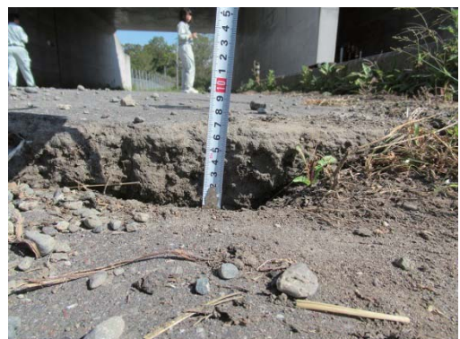
写真 4.2.5 路面の段差
