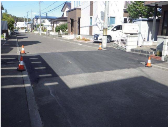
写真 3.2.4① 豊平区月寒東三条の被害状況
