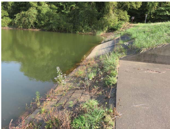
写真 5.2.17 ため池 堤体上流側
