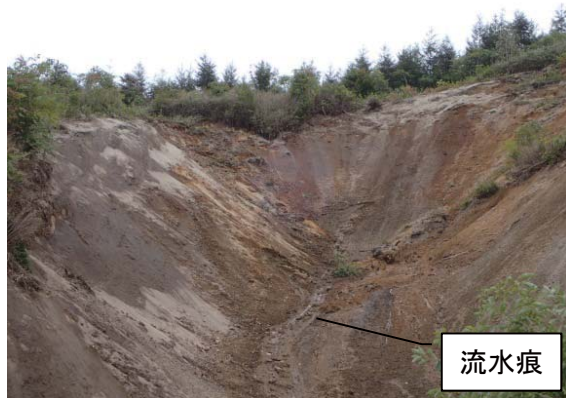
写真 2.2.20 東和地区崩壊地の頭部
