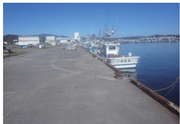
写真 6.2.5 白老港（被害なし）
