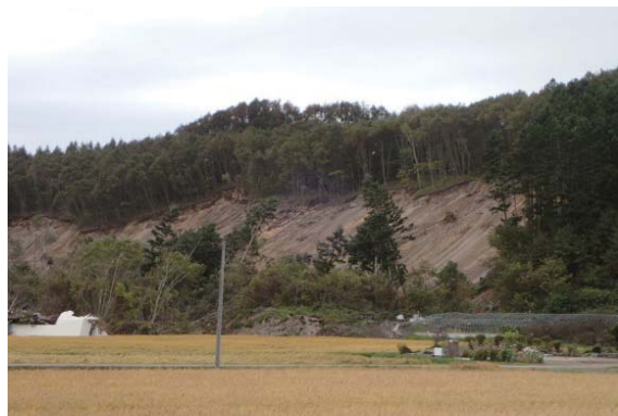
写真 2.2.17 崩壊地 C の遠景
