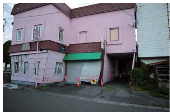
写真 7.1.1 むかわ町中央通りでの建物被害
