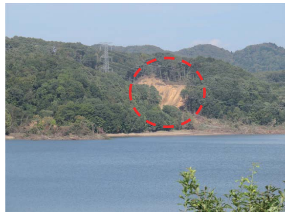
写真 5.2.8 瑞穂ダム 貯水池右岸斜面崩壊
