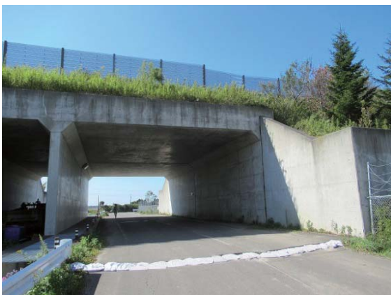
写真 4.2.1 カルバート正面部
