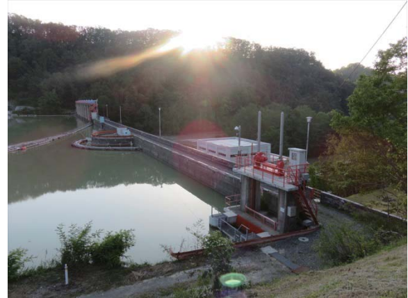
写真 5.2.1 川端ダム ダム本体
