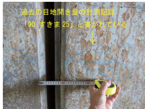
写真 4.2.13 目地開き量の計測状況
