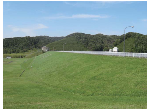
写真 5.2.7 瑞穂ダム 堤体
