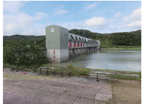
写真 5.2.13 二風谷ダム 堤体
