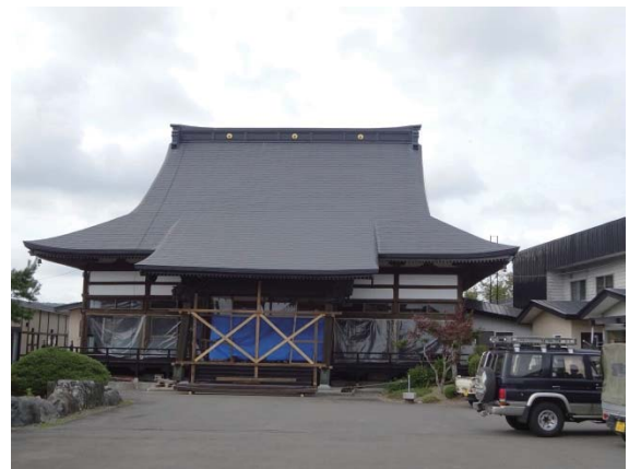
写真 7.2.3 被災した寺院(厚真町表町)
