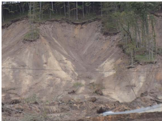
写真 2.2.24 崩壊部の拡大写真
