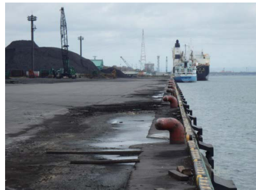
写真 6.1.5 晴海ふ頭岸壁の状況
