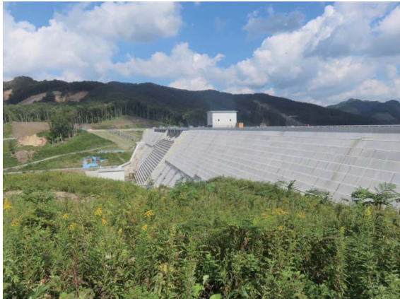
写真 5.2.10 厚幌ダム 堤体
