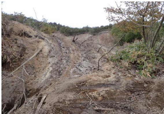
写真 2.2.16 崩土の流走痕
