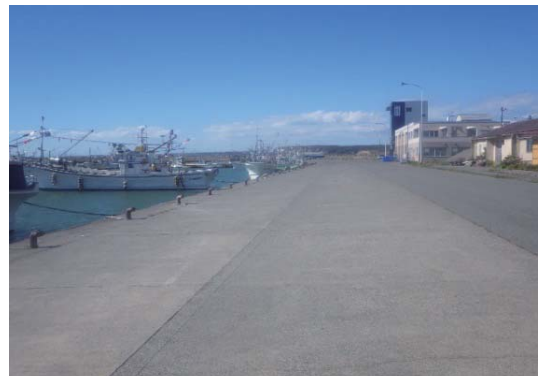
写真 6.2.10 厚賀漁港（被害なし）
