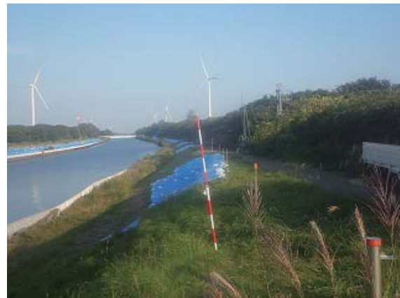
写真 5.1.5 石狩放水路 (河口部左岸 0.1k より撮影)
