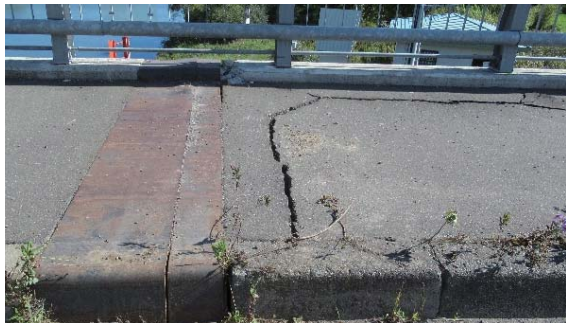
写真 4.1.32 路面の亀裂
