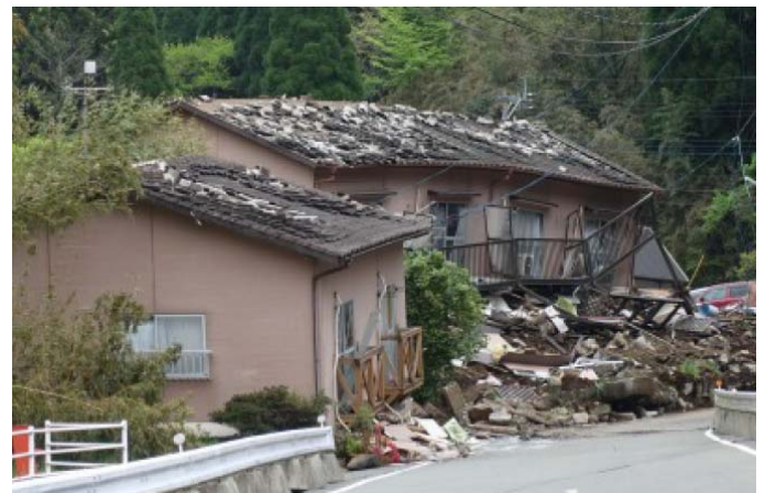
南阿蘇村 木造アパートの倒壊と道路閉塞
