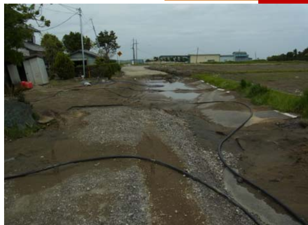
東日本大震災稲敷市(震度5強程度) 噴砂と電柱傾斜
