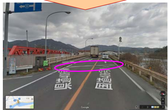
矢掛町 国道486号新栄橋
