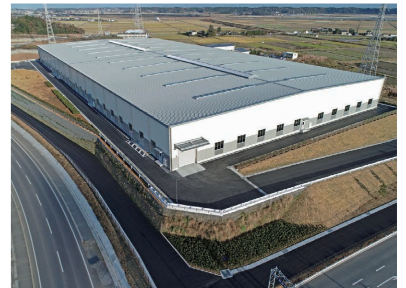
水戸市一般廃棄物第三最終処分場（茨城県）
