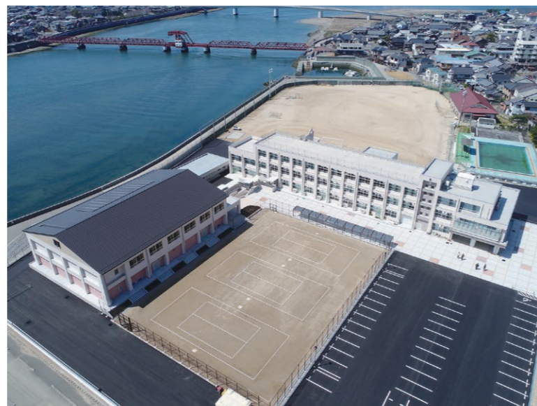
大洲市立長浜中学校PFI事業（愛媛県）
