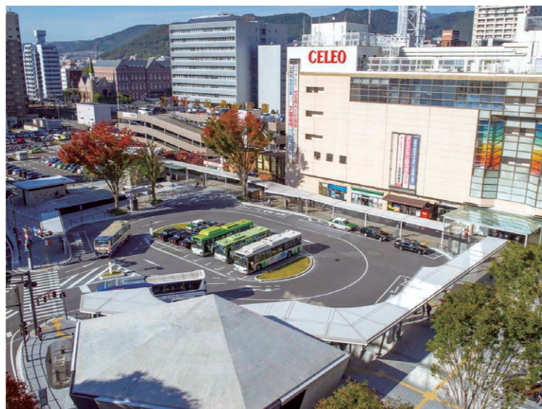
甲府駅南口駅前広場(山梨県)
