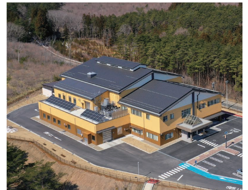
久慈広域連合汚泥再生処理センター（岩手県）
