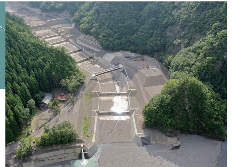
赤谷1号砂防堰堤、溪流保全工(奈良県)
