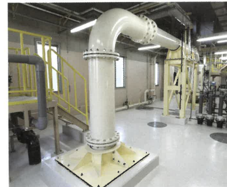
■酸素溶解循環配管(Uチューブ)
