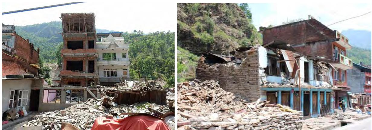
写真-7.5 倒壊を免れた建物も石積の建物
