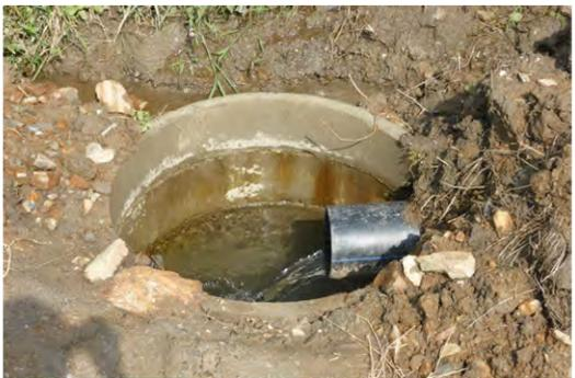
桝を設置し湧水の一部を処理している
