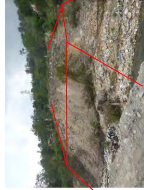
盛土を行う場合には盛土自体の安定が確保されるように盛土材の強度の確認が必要。また別途は盛土の排水路を設置する必要がある。詳細検討にあたっては、河川のピーク流量や流速の確認が必要。
