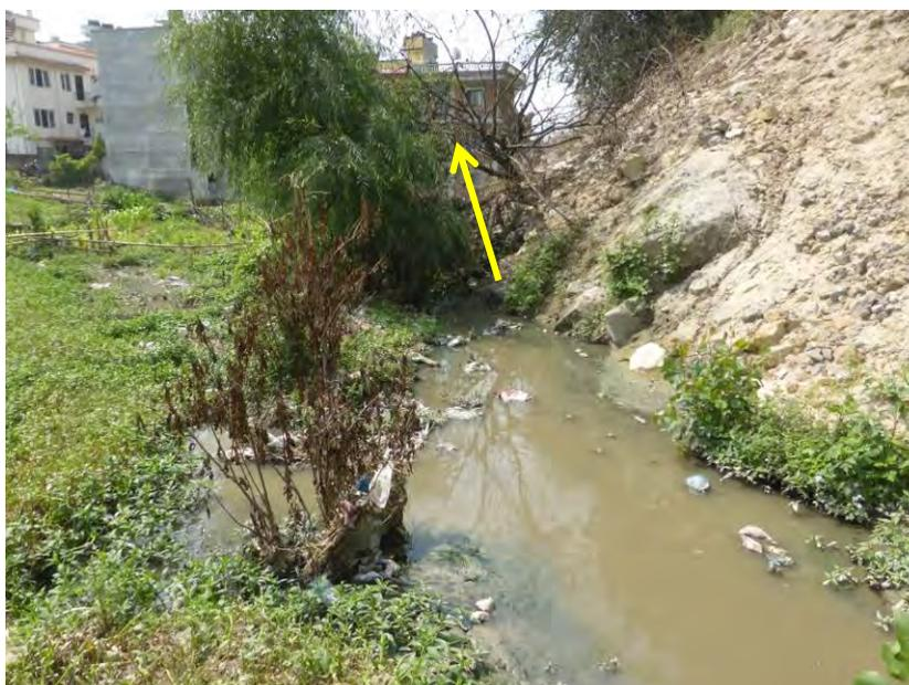
崩壊地上流側より下流側を望む。崩壊地下流に民家があり、閉塞部が決壊した場合には民家を直撃する可能性がある
