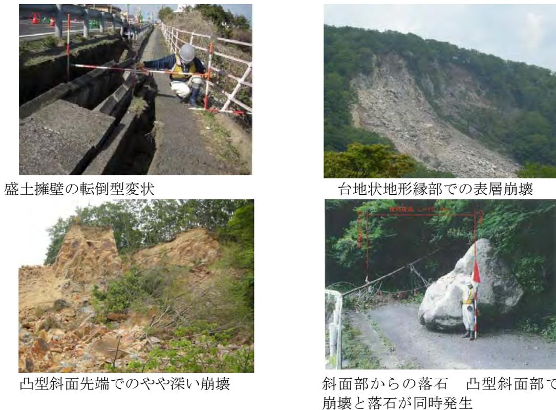
写真-4.37 東日本大震災の被害形態 (低地下水位地帯)
