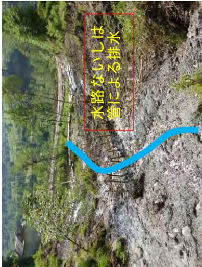
溝を掘り、湧水を確実に排水する
