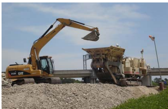
図6 多賀城市 コンクリ破砕機
