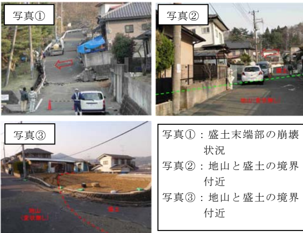
写真1 未対策造成地盤の被害状況(折立地区)
