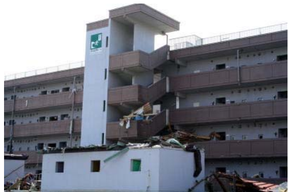
写真 3 典型的な津波避難ビル (南三陸町の町営住宅)
