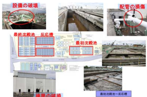
図1 南蒲生浄化センター被災状況
