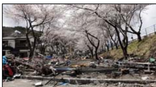
写真7 嬉石公園の被災状況
