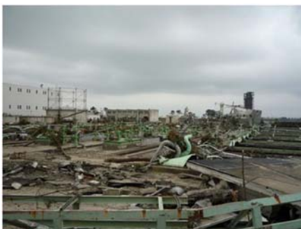
写真8 津波発生後の南蒲生浄化センター —被災状況(仙台市 Web)
