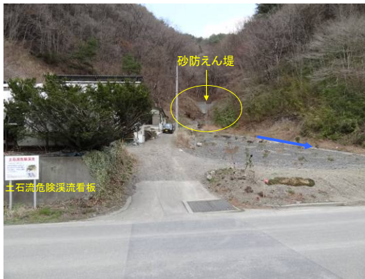
写真5 土石流危険溪流の砂防えん堤
