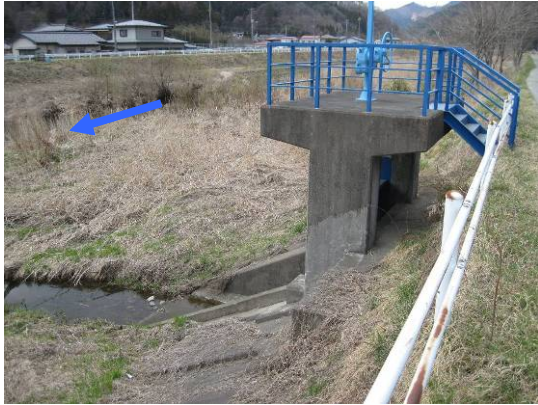
写真4 河川構造物の樋門
