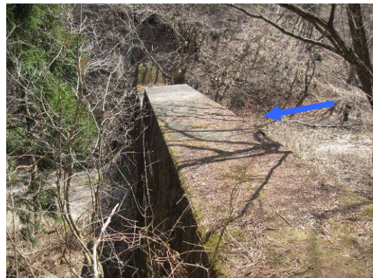
写真14 長内川右支川 河口から1.5km地点の砂防えん堤工の状況 (異常なし)
