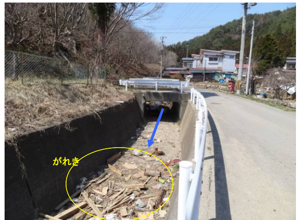
写真15 長内川右支川 河口から1.0km地点の流路工の状況 (流路工には被害なし)
